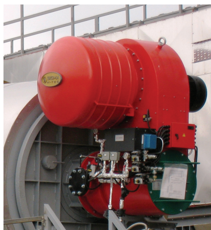
Многотопливная моноблочная горелка SIGMA оснащена мощным вентилятором и современным глушителем
