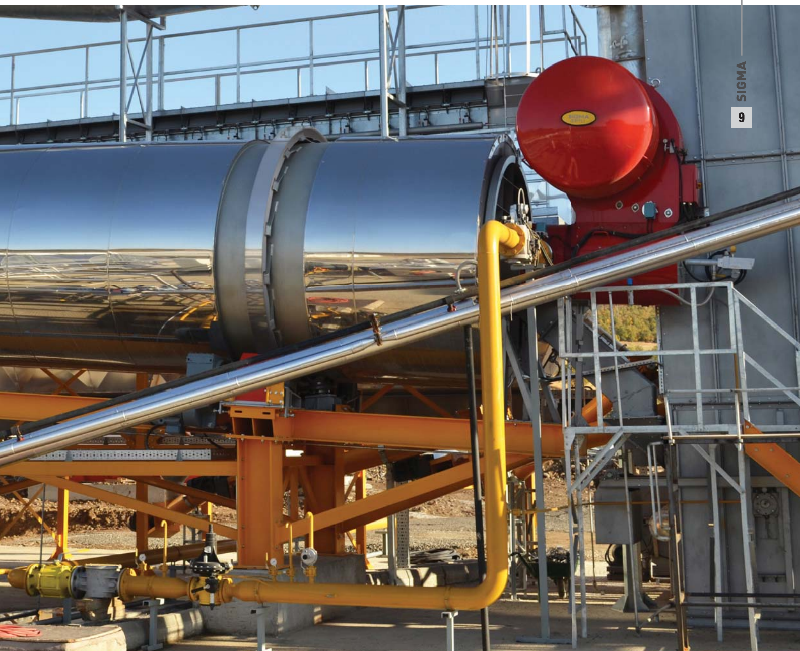
Высокоэффективная моноблочная горелка Highly efficient monobloc burner
