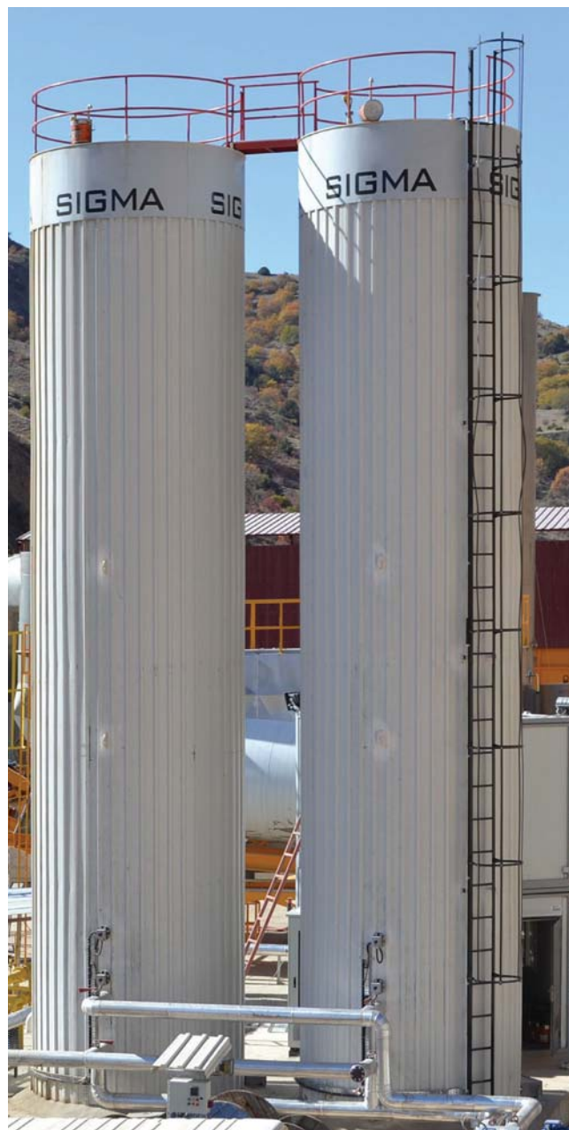
Вертикальные битумные емкости объемом 70 м³ 70 m³ vertical bitumen tanks
