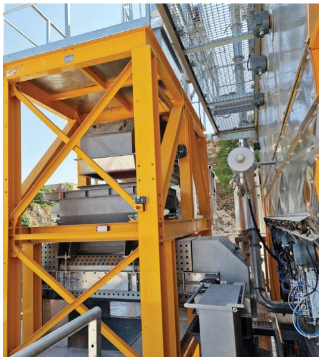
Дозирование рециклингового асфальта / Recycling dosing
